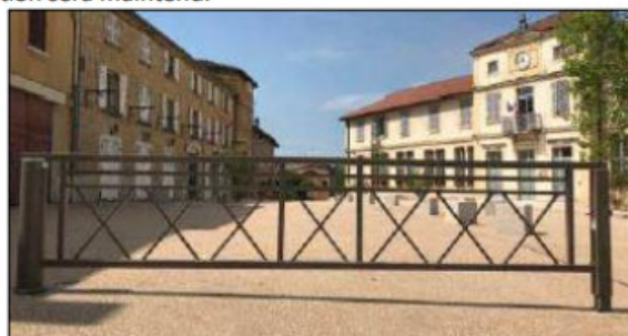
Figure 52 : Dispositifs de restriction d'accès
